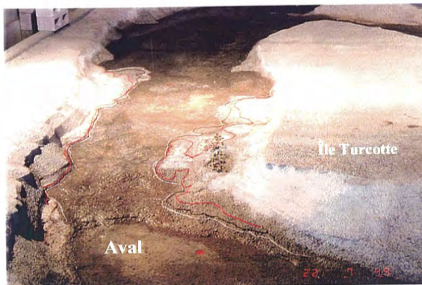
Bras droit en conditions actuelles vu de l'aval, niveau de lac 21.24m
