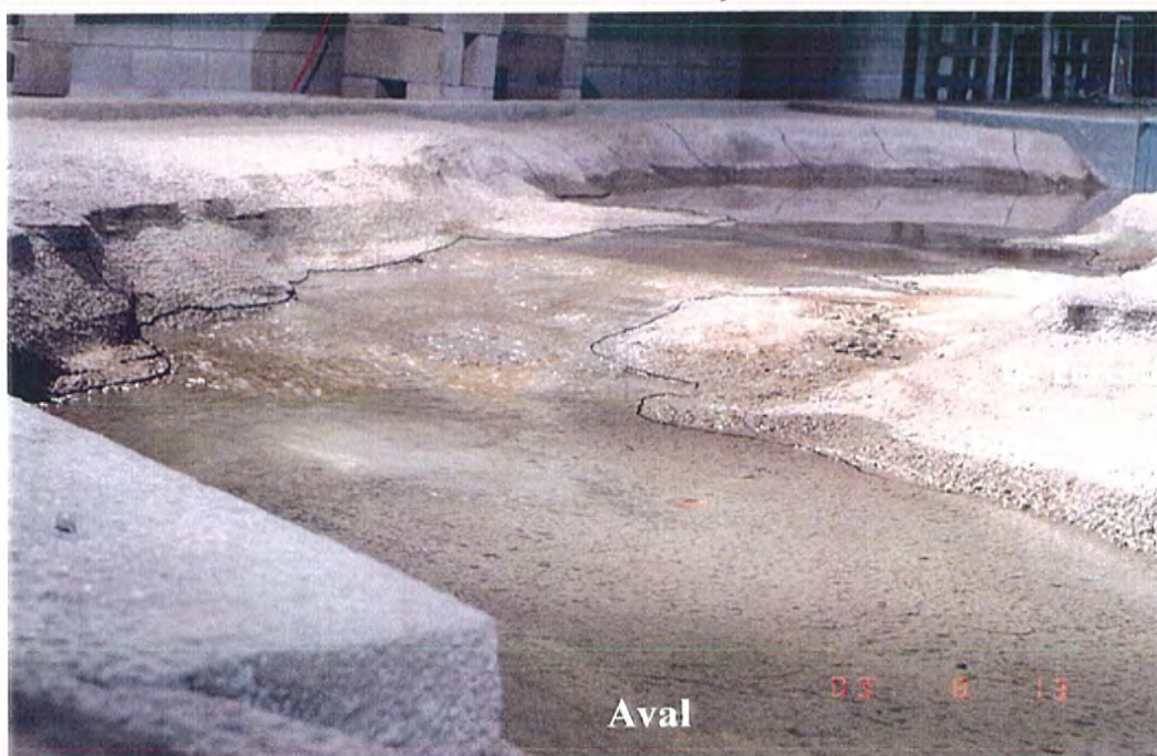
Bras droit vu de l'aval, scénario B, niveau du lac 21.24m
